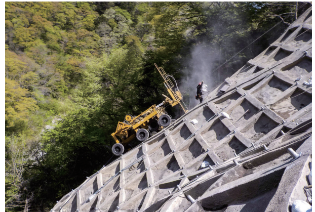
ARM07の施工状況
