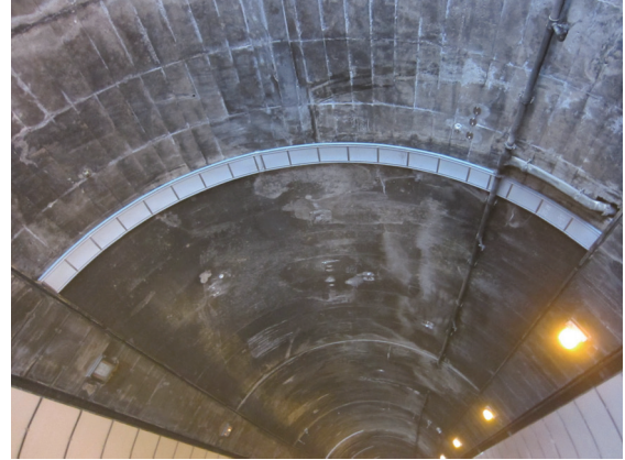
アーチ・ドレン施工現場 (笹子トンネル)
