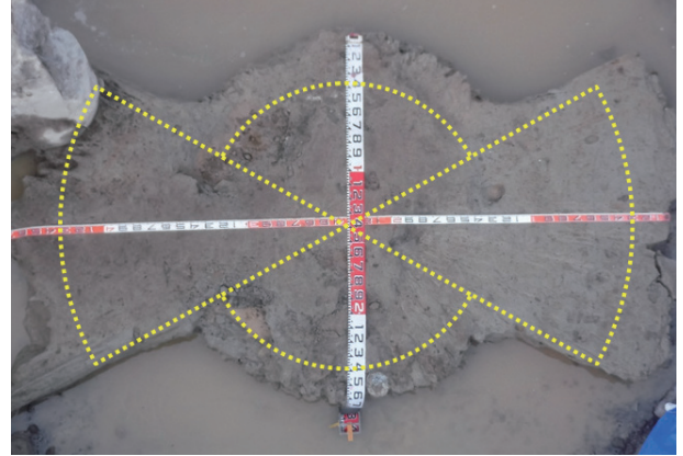
マルチファン工法による多扇形の改良体
