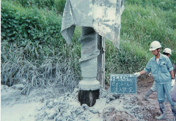
セメントミルク注入
