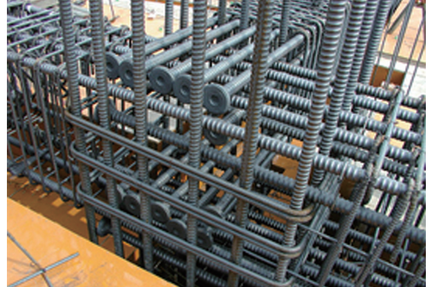
梁主筋定着での使用状況
