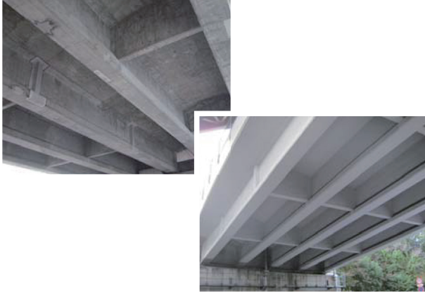
RT ワンガード工法 (施工前→施工後)
