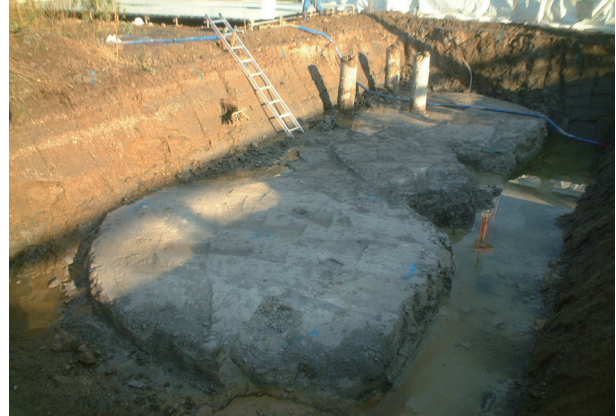
改良体出来形状況
