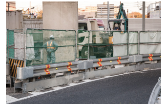
架道橋耐震補強工事での設置例
