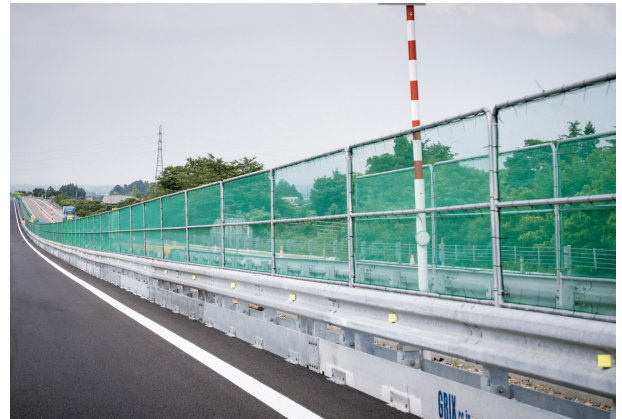
目隠しネット設置状況 (GX-KSH-8・東海北陸自動車道)
