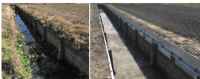
施工例（左：施工前、右：施工後 全長100m、工期1日）
