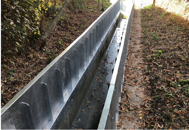
施工例（山梨県上野原市）
