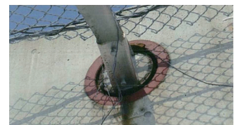
下部補強棒を挿入した場合
