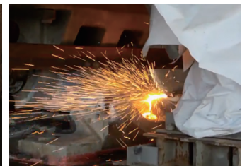
橋梁耐震装置の撤去
