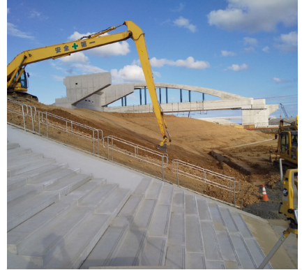
スーパーロングアームのBHでも刃先 座標を直接取得可能なため使用可能
