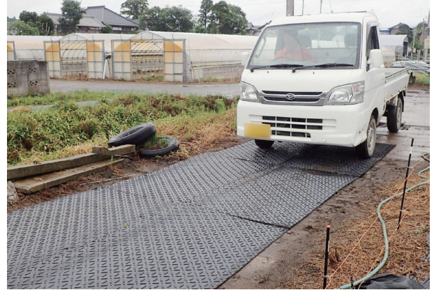
軽トラ通路養生
