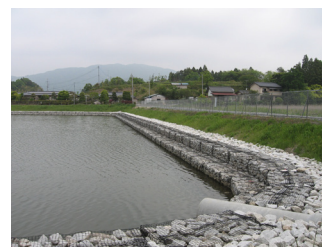
調整池護岸工（カゴタイプ）
