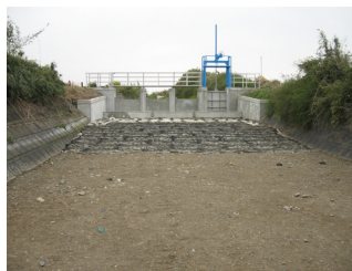
堰堤防護床工（スロープタイプ）
