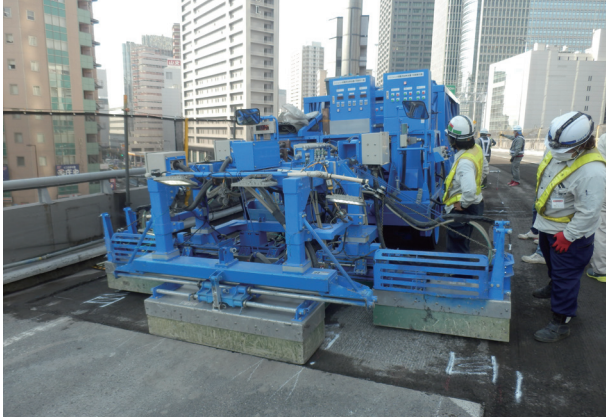
IH加熱パネルによる加熱・撤去状況
