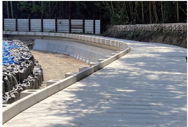
施工実績 (道路整備工事)
