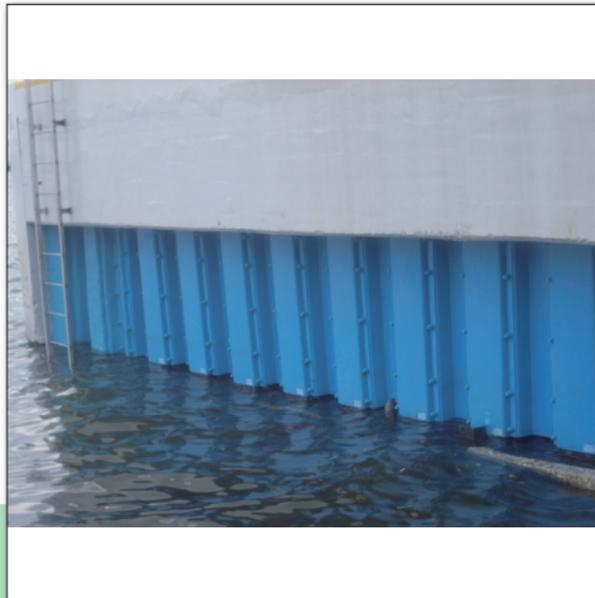
「ペトロラタム被覆工法」は防食性能の優れたペトロラタムテープと、これを保護するFRPカバーを組み合わせた防食システムである。海洋環境の中でも最も過酷な腐食環境にある、飛沫干満帯に対して効果的な防食技術である。
