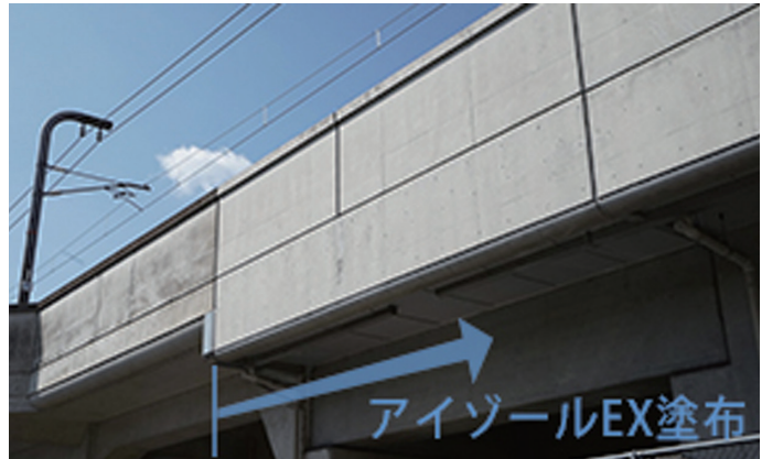
施工例 (施工後13年経過)
