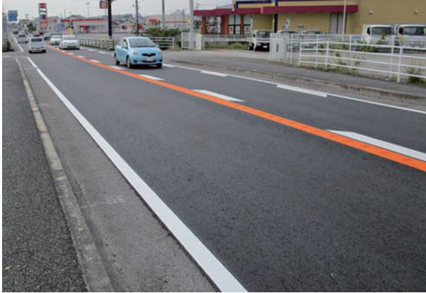
N6交通量 施工例
