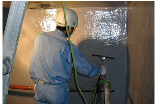
ピンホール検査状況
