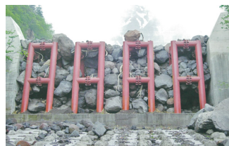
既設堰堤改良後、土石流捕捉事例：北海道 利尻島 (鋼製スリットダムB型)
