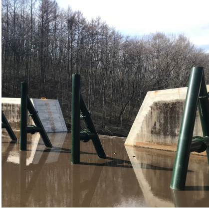
鋼製スリットダムA型(群馬県 長井川)
