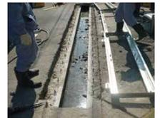
③ドリルで削孔後、差筋を設置
