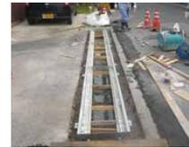
⑤受枠内側に型枠を取り付ける
