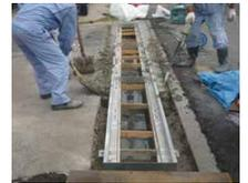
⑥早強生コンクリートを打設し締め固める
