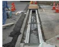
④本製品の受枠を設置しボルトで高さ調整
