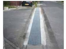
⑨グレーチング設置後、ボルトで固定し完成
