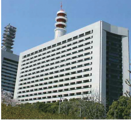
ピュアコート®施工実績（警視庁本部庁舎、施工2017年）
