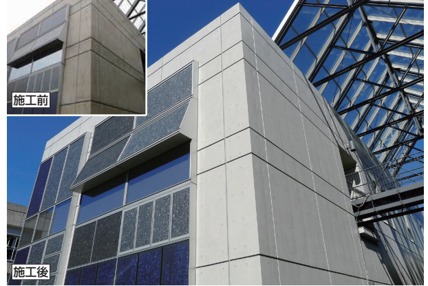
ピアレックスRC工法施工実績（鹿島建設技術研究所、施工2007年）
