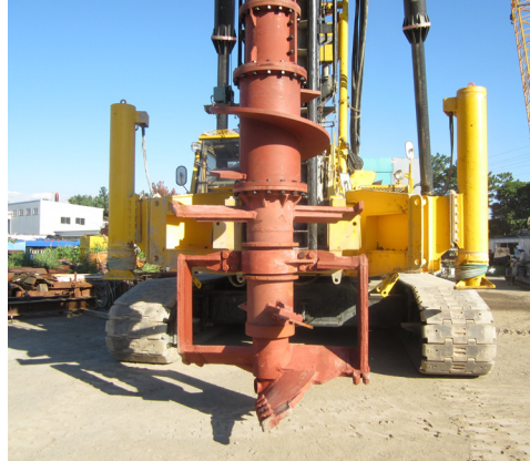
掘削・攪拌翼先端
