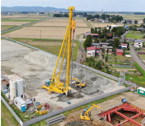
KS-S・MIX工法施工状況 (全景)
