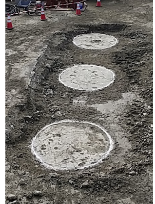
改良杭 (杭頭部)
