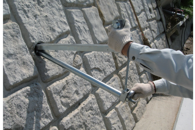
ゴムリング部まで水抜きパイプに差し込んで設置する
