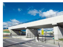
国道161号青柳第2高架橋 (近畿地整)
