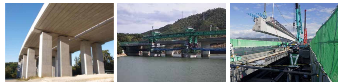
沖縄自動車道億首川橋 (NEXCO西日本)
