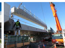
中津水足線橋梁 (加古川市)
