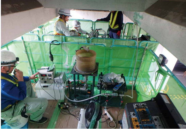
施工状況 (注入状況全景)
