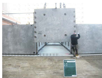
端面D部材（外側より撮影）
