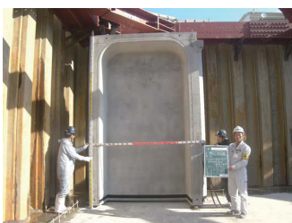
端面B部材（内側より撮影）
