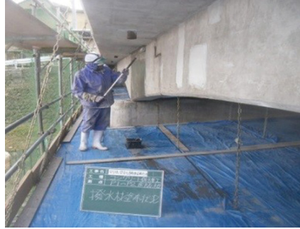
橋脚の防水・保護のために塗布（左：橋脚全景
