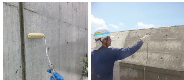
Sクリート工法の施工状況
