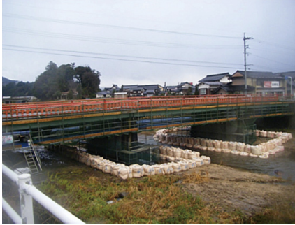
橋脚の防水・保護のために塗布（左：橋脚全景
