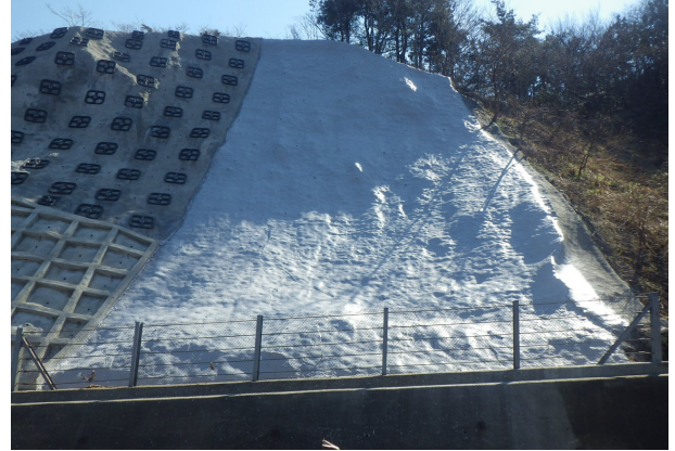
ELAST GUARD工法による老朽モルタル修復後
