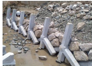
①1段目据付状況
