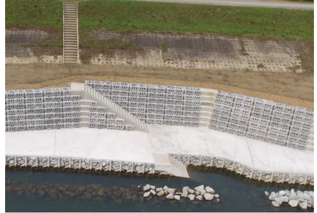
施工事例：兵庫県豊岡市 1級河川円山川護岸改修工事
