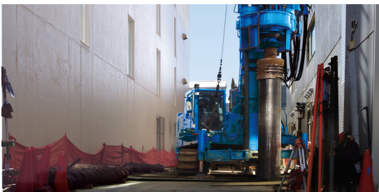
杭径：φ609.6mm以下の建築・土木分野
