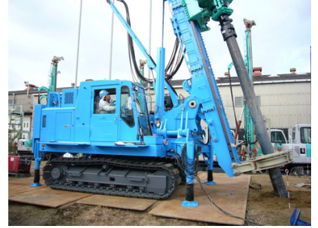
斜杭施工状況
