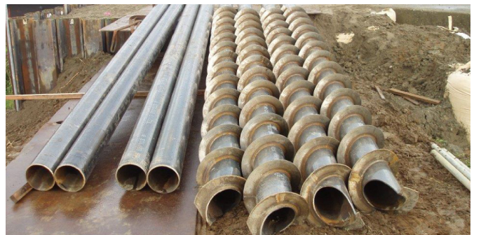
杭径：φ700mm以下の建築・土木分野
