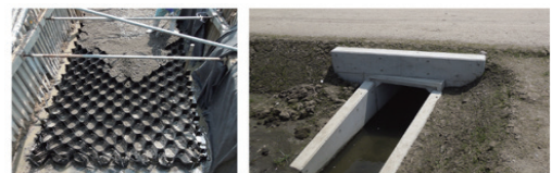
ボックスカルバートの基礎
