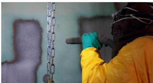
粉塵の発生が極めて少ない施工状況
