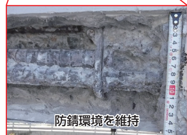
補修20年経過後の鉄筋の状況
