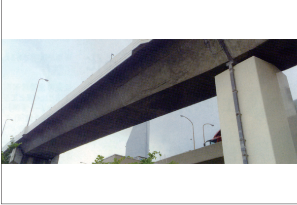
RT-ワンガードクリア工法施工例
