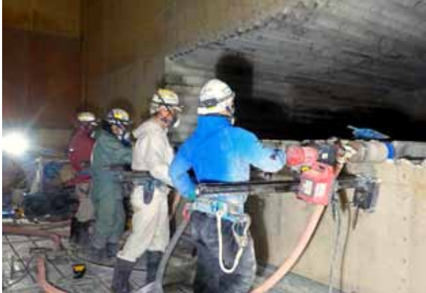
連続コアによる壁面削孔状況
