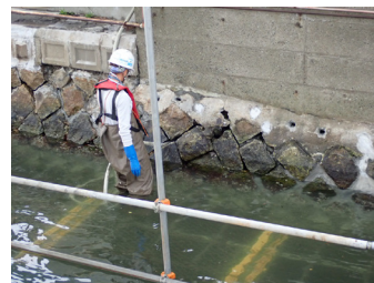
水上部打設状況
