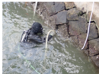
水中打設状況
