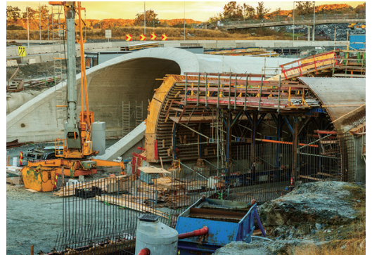
導入現場例（トンネル工事）
