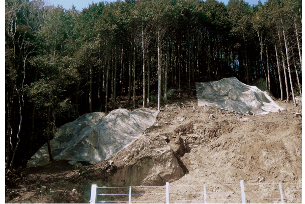
施工事例 (兵庫県)
