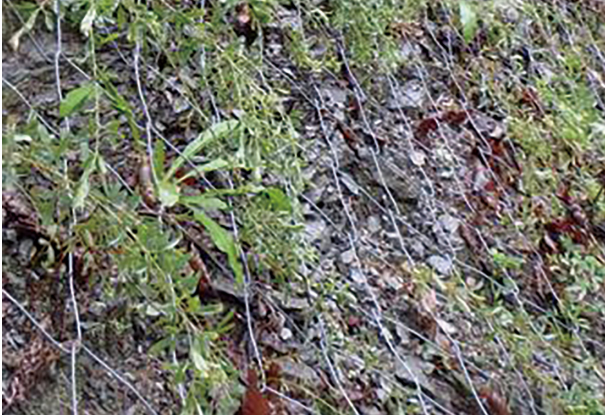
デルタックス工法による補強例
