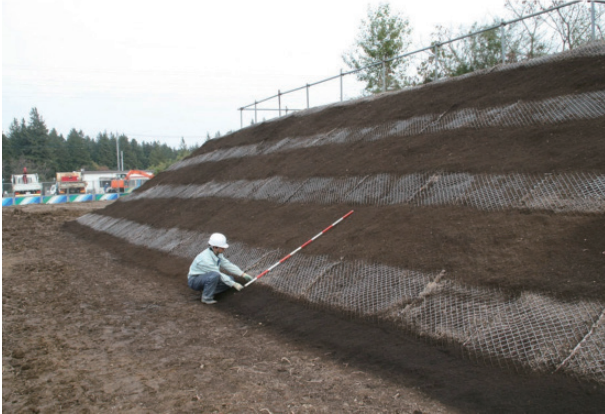
エコストライプ工法 (施工直後)
