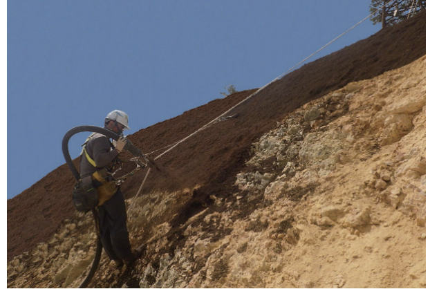
ノンラスグリーン工法 (施工中)
