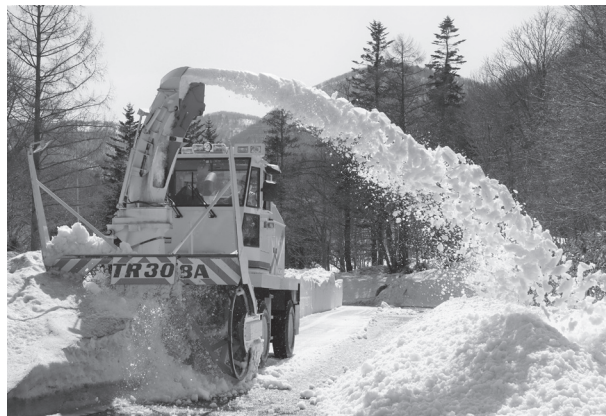
除雪作業状況
