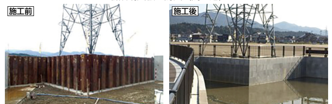
新設鋼矢板の防食（調整池）
