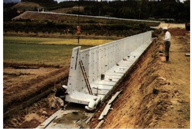
擁壁の施工事例 (擁壁の建込み状況)
