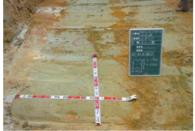
出来形(杭頭確認状況)
