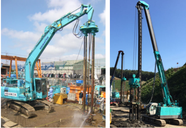
施工機(左:自動姿勢制御方式工機、右:ガイドリーダ方式工機)
