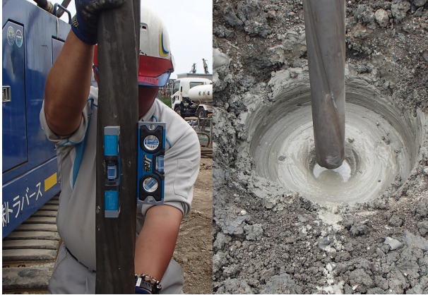
らせん溝付鋼管建て込み状況
