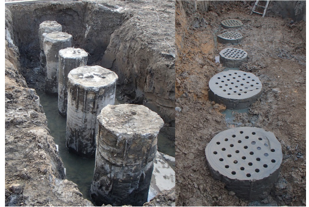
試験体掘り起こし及びコア抜き試験状況
