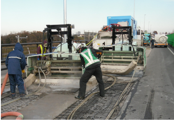
施工状況 (床版面はつり)
