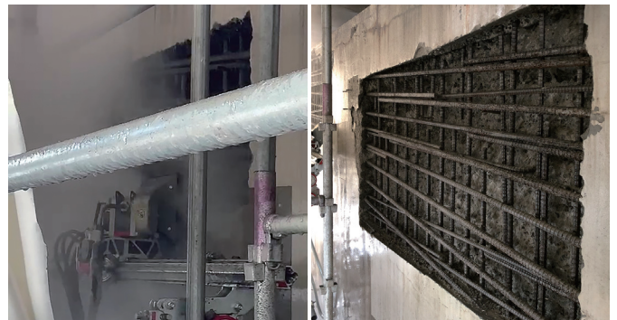
XY壁面はつり状況
