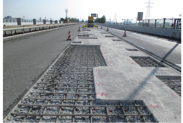
施工状況 (床版面はつり後)
