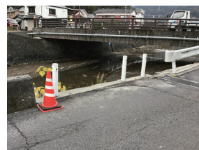
均しモルタル
