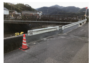
ガードレール取付け
