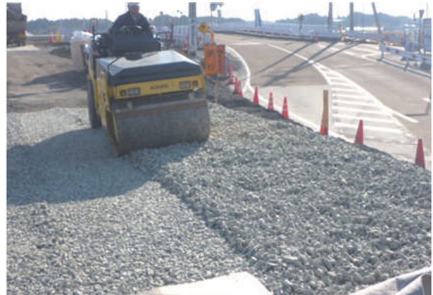
路床・路体での施工時写真
